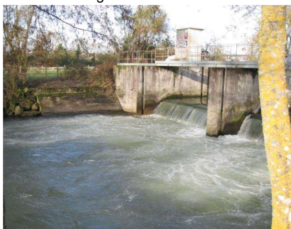
Figure 10 : Clapet des Grands Près à Vendôme (CATV)
